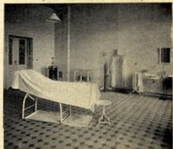
Sala operacyjna w szpitalu Tow. Akcyjnego R. Kindlera w Pabianicach.
